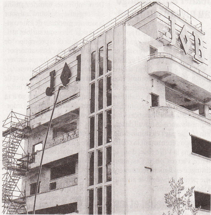
Le bâtiment Job où les travaux ont commencé. Photo archives DDM
